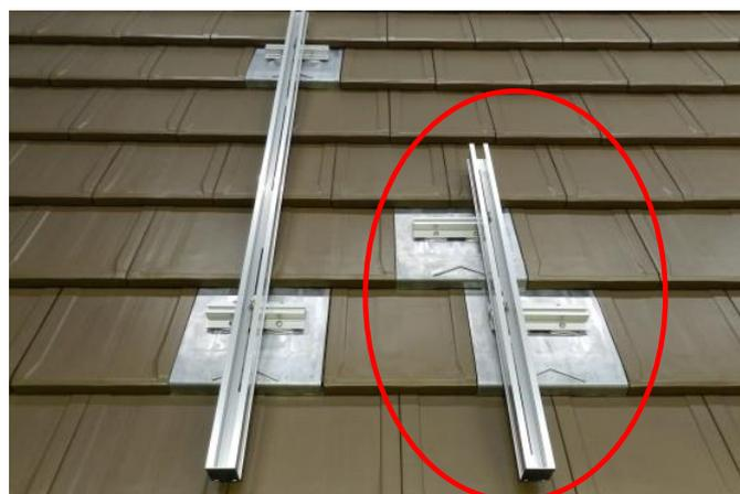
マウント金具のスライド機能により平板瓦の連続配置が可能となり縦ラックの割り付けが容易になります。
