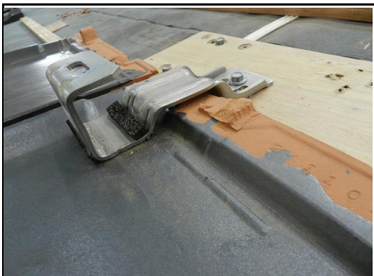
■平-1型金具を取付け、真横から撮った写真
