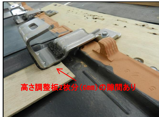
■平-2型金具を取付け、真横から撮った写真 高さ調整板2枚分(6mm)の隙間あり
