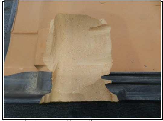
■瓦(裏)を加工した拡大画像(平-2型用)
