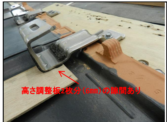
■平-2型金具を取付け、真横から撮った写真 高さ調整板2枚分(6mm)の隙間あり
