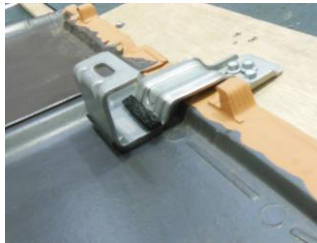
・桟木(15.0t)で施工
