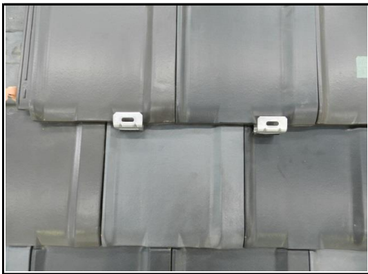
■真上から撮った、瓦を収めた写真
